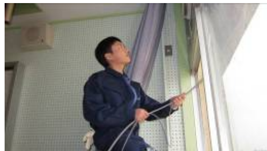
( NOAAアンテナからの通線作業 )
