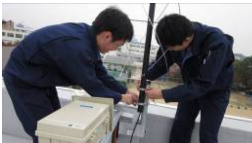
( 小学校屋上へNOAAアンテナの設置作業 )
